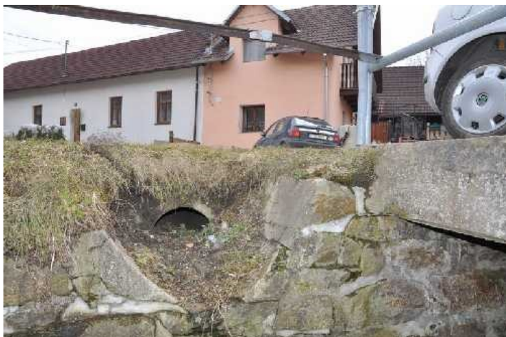
Zanesené vyústění kanalizace na návodní straně mostu.
