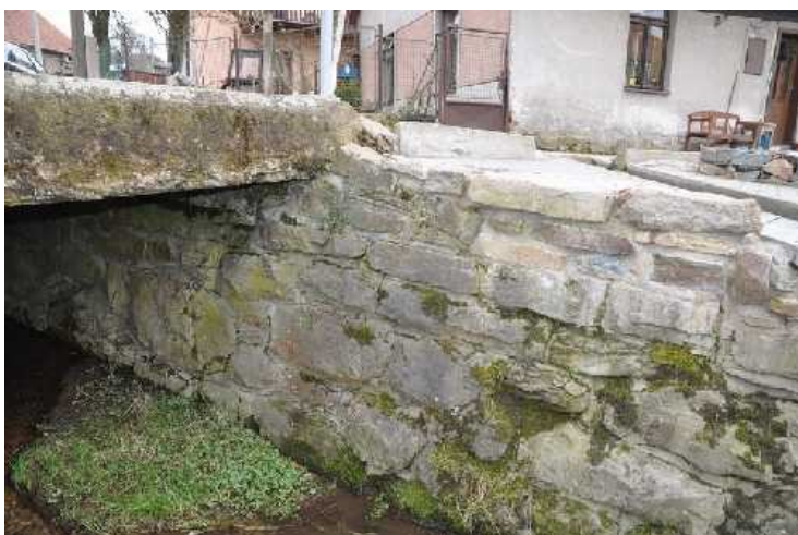
Nosná konstrukce současně slouží i jako římsa.
