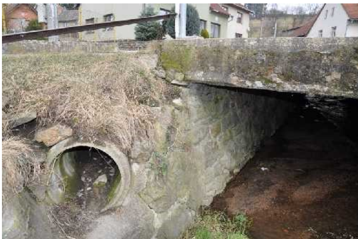
Vyústění kanalizace pod mostem.
