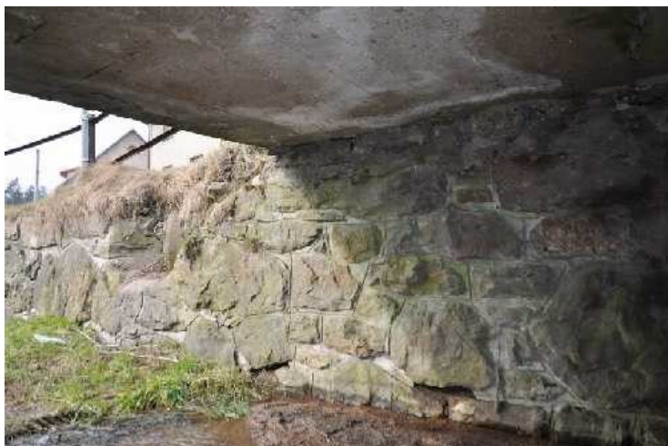
Povodní strana nosné konstrukce s opěrou 1.
