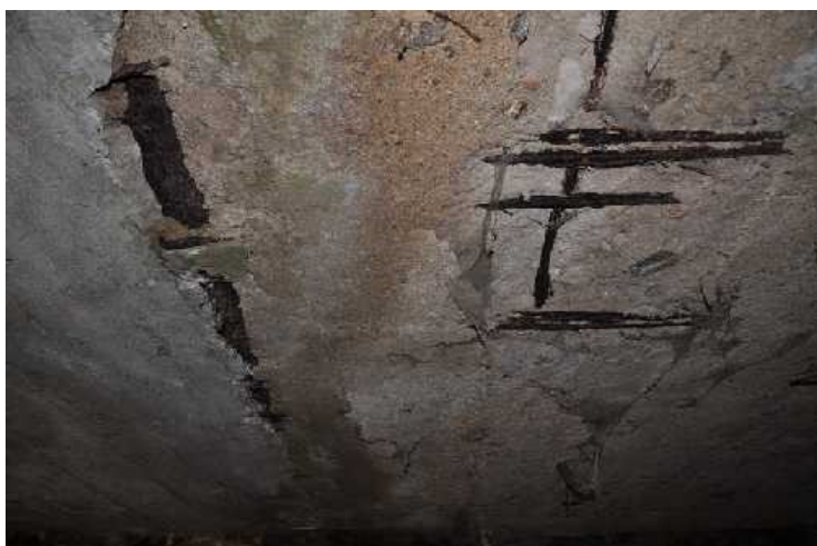
Obnažená tuhá i betonářská výztuž vlevo na návodní straně. Betonářská výztuž je úplně oslabená korozí.
