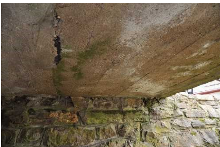
Obnažená tuhá výztuž vpravo na povodní straně.
